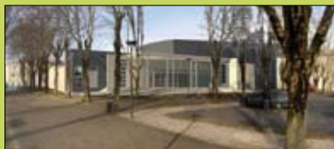
Salle de colloque © Favreau-Barranger architectes
