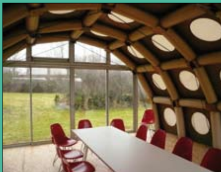
Structure en bois et carton, du Japonais Shigeru Ban. Domaine de Boisbuchet. Photo © MDAPC
