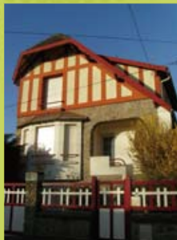
Villa de style balnéaire, Parthenay © Atemporelle
